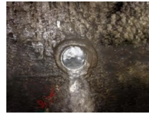
图3 排水管结晶
